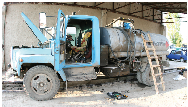
Монтаж системи контролю видачі палива на мобільний паливозаправник
